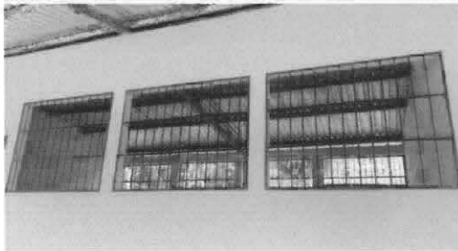
Foto 3: Fabricación e instalación de ventana-balcon de metal
