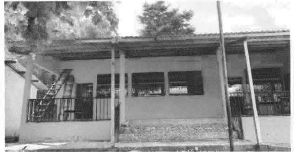
Foto 8:Estructura de techo
