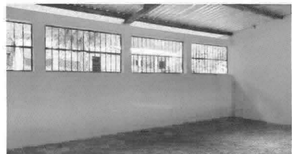
Foto 6: Pintura en muros interiores
