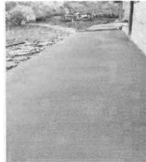
Foto 4: Reparación de torta de piso de concreto
