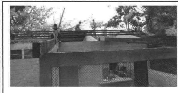
Foto 5: Desinstalación de lámina
