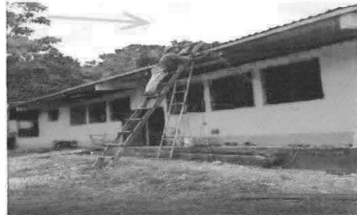
Foto 2: Sustitución de soporte o pescante de metal para canal
