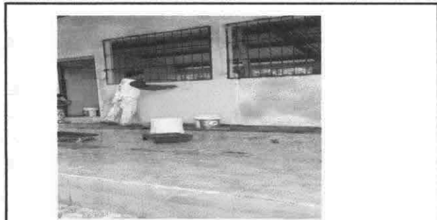
Foto 6: Pintura en muro exteriores e interiores
