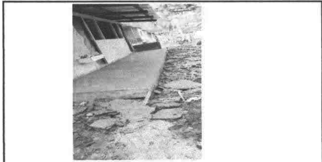
Foto 4: Torta en reparación
