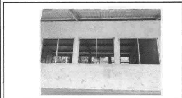
Foto 3: Sustrucción de balcones de Metal
