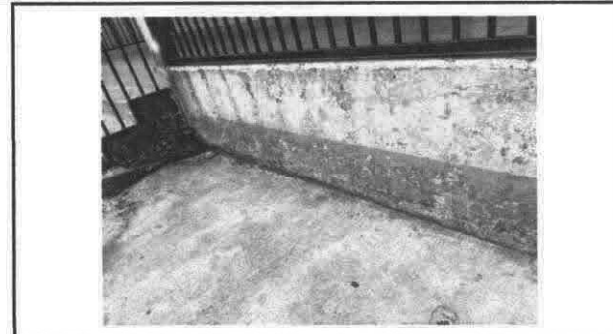
Foto 2: Repello en muro
