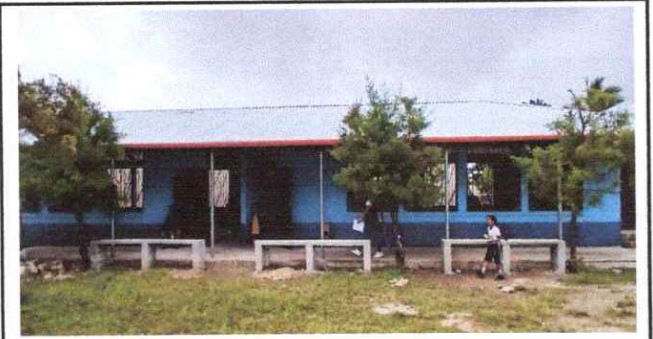
Foto1: Lamina nueva instalada
