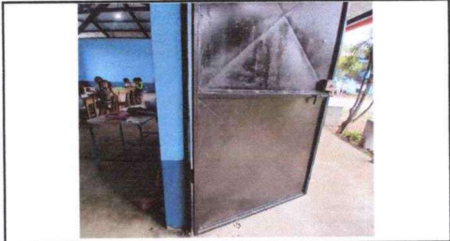
Foto 3: Puertas reparada y mantenimiento realizado
