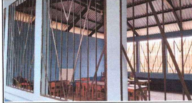
Foto 4: Balcones lijados y pintados
