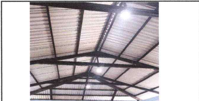
Foto 6: sistema Eléctrico reparado
