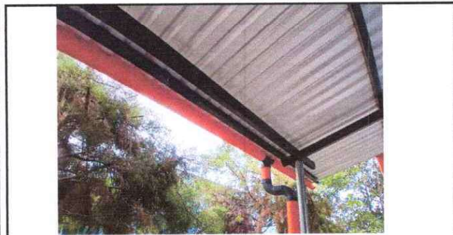
Foto 5: Canales de PVC ya cambiados
