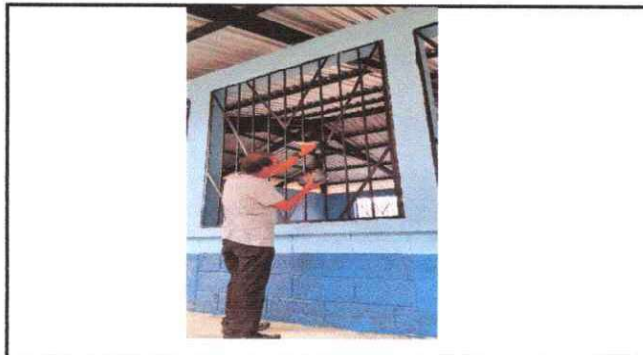
Foto 4: pintura y mantenimiento a balcones
