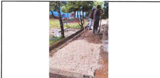
Foto 6: reparacion de Banqueta en mal estado
