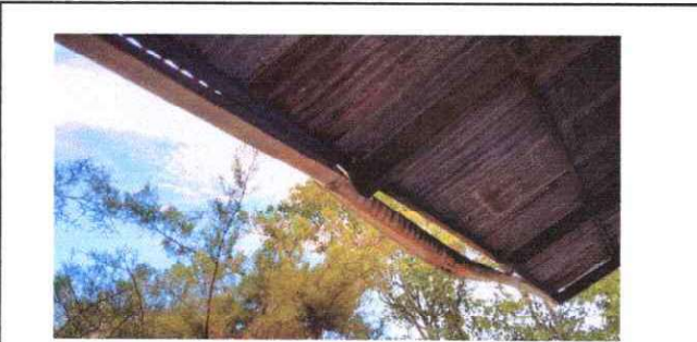
Foto 5: cambio de canales de PVC dañados
