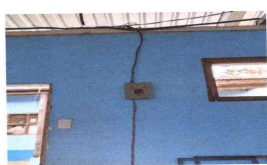
Foto 8: SUSTITUCION DE FLIPON
