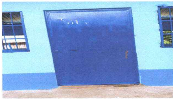
Foto 3: FABRICACION E INSTALACION DE PUERTA DE METAL EN MODULO
