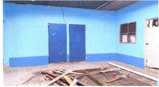
Foto 4: FABRICACION E INSTALACION DE PUERTAS DE METAL EN BAÑOS
