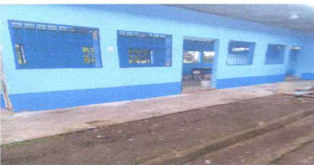
Foto 5: FABRICACION E INSTALACION DE BALCONES DE METAL
