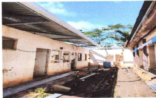
Foto 3: FABRICACION E INSTALACION DE PUERTA DE METAL EN MODULO
