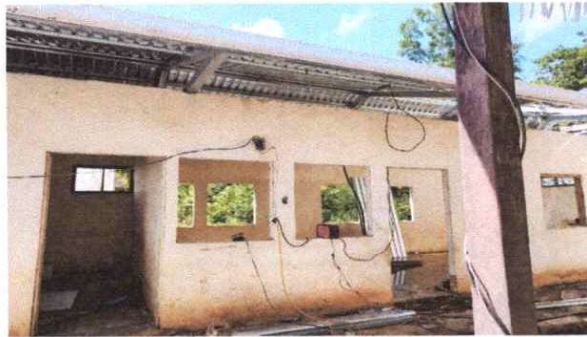
Foto 9: REPARACION DE CABLEADO ELECTRICO+ ACCESORIOS
