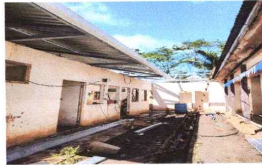
Foto 4: FABRICACION E INSTALACION DE PUERTAS DE METAL EN BAÑOS
