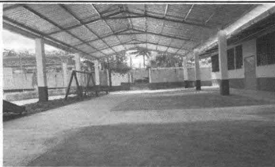
Foto 5: SUSTITUCIÓN DE PISO DE TORTA DE CONCRETO
