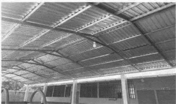
Foto 3: CAPOTES INSTALADOS SOBRE LAMINA TROQUELADA
