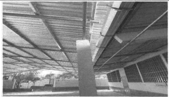
Foto 4: COLOCACIÓN DE CANALES PARA BAJADA DE AGUA
