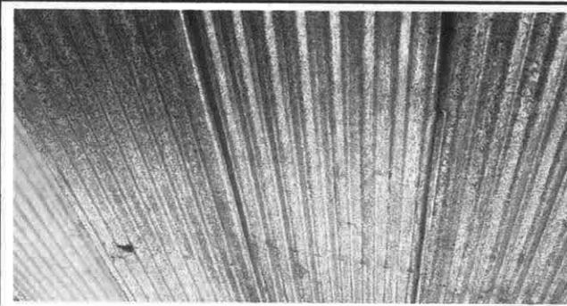
FOTOGRAFIA 3: SUSTITUCIÓN DE LÁMINA
