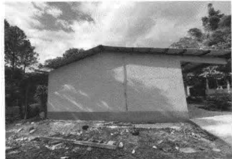
Foto 6: Pintura en muros exteriores e interiores.
