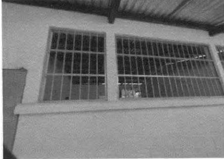
Foto 1: Mantenimiento a Balcones de metal
