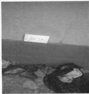
Foto 3: Sustitución de tomacorrientes dobles
