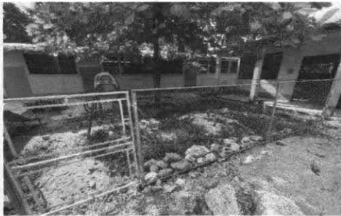
Foto 3: Reparación de muro perimetral
