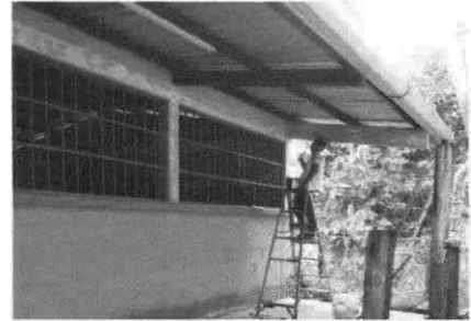
Foto 2: Cambio de estructura de madera por metal
