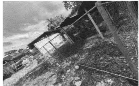
Foto 4: Reparación de tubo HG y malla galvanizada
