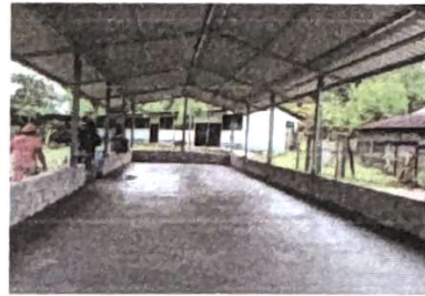
Foto 10: REMOZAMIENTO EN CUBIERTA
