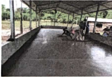
Foto 9: REMOZAMIENTO EN SUELO
