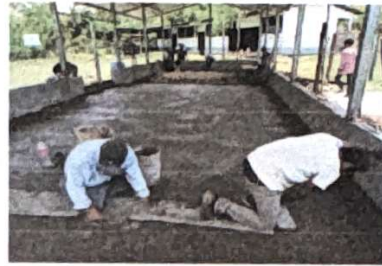
Foto 8: REMOZAMIENTO EN SUELO
