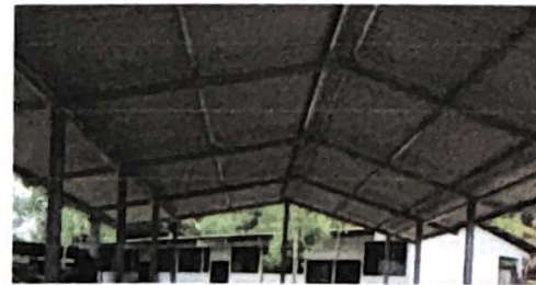
Foto 6: REMOZAMIENTO EN CUBIERTA
