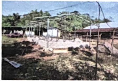
Foto 7: REMOZAMIENTO EN AULA
