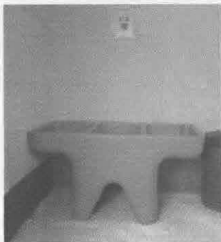
Foto 3: Sustitución de pila de Cemento de dos lavaderos
