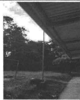
Foto 6: Sustitución de Canal de metal
