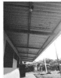
Foto 6: Sustitución de Plafoneras
