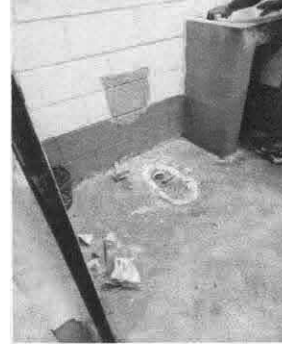
Foto 2: Sustitución de inodoro
