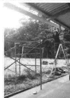
Foto 6: Sustitución de Canal de metal
