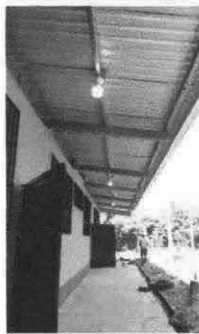
Foto 5: Sustitución de Lampara tipo led
