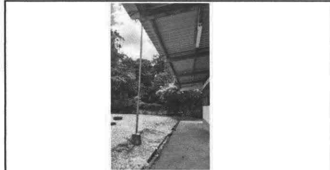
Foto 6: Sustitución de plafoneras
