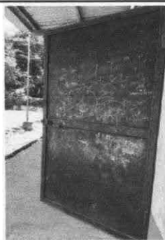
Foto 5: Mantenimeinto de Estructura ( Lijado ,cambio de tubo, cepillado, sujeciones, aplicación, pintura)
