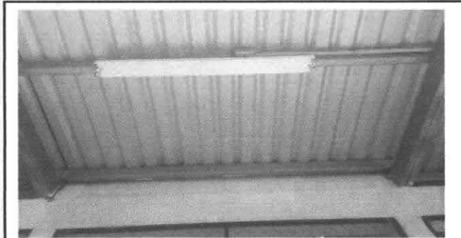
Foto 5: Sustitución de lampara tipo led
