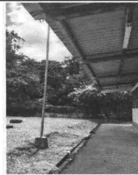
Foto 6: Sustitución de Canal de metal
