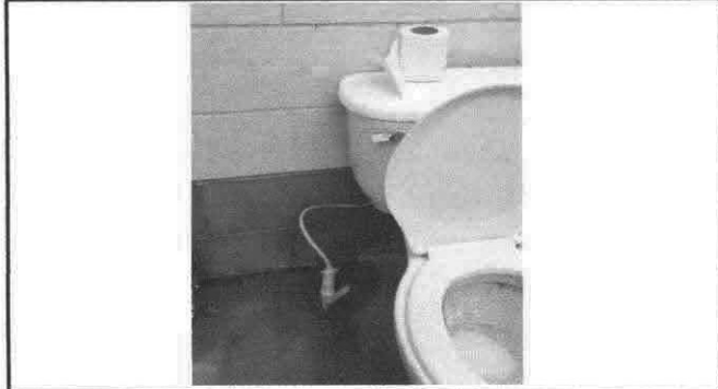
Foto 2: Sustitución de inodoro
