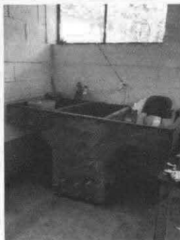
Foto 3: Sustitución de pila de Cemento de dos lavaderos
