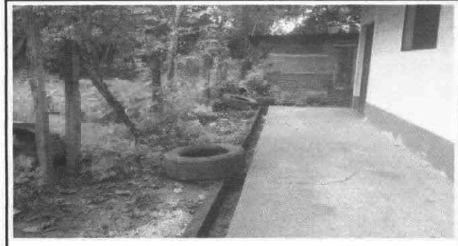
Foto 4: Reparación de cerco de alambre de pua
