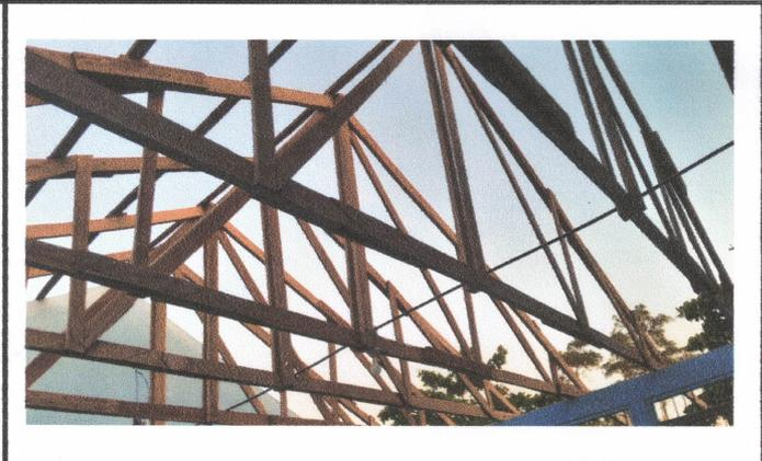
Foto 3: Sustrucción de estructura de soporte de madera, por metal.
