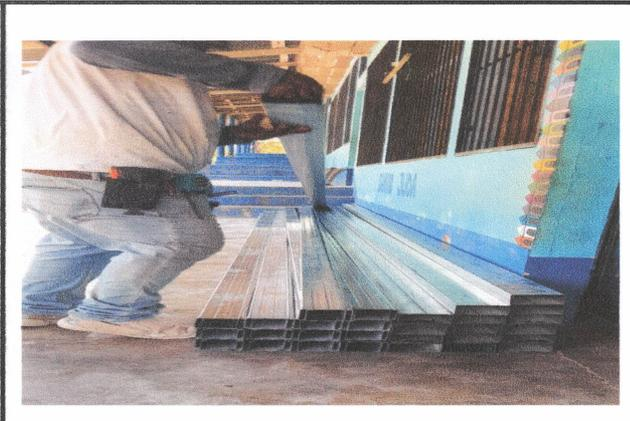
Foto 4: Sustrucción de estructura de soporte de madera, por metal.
