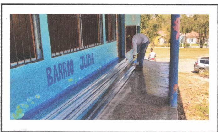
Foto 5: Sustrucción de estructura de soporte de madera, por metal.
