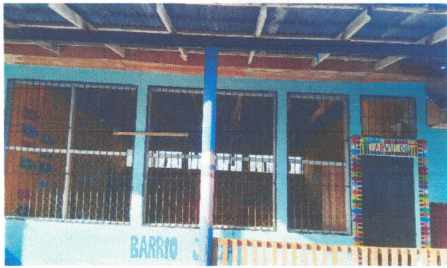
Foto 3: Sustitución de estructura de soporte de madera, por metal.
