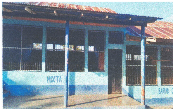
Foto 4: Sustitución de estructura de soporte de madera, por metal.
