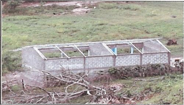
Foto 1 Renglon 2.2 Sustitución de estructura de soporte de madera, por metal
