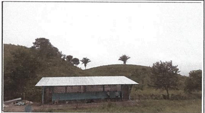
Foto 2 Renglon 1.1 Sustitución de lamina por lamina troquelada de calibre 26
