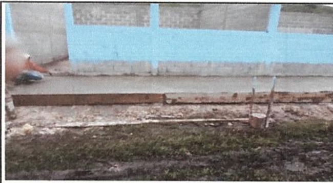
Foto 4 Renglon 6.5 Sustitucion de piso de torta por concreto
