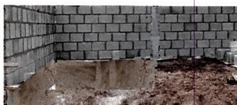
Foto 5: Sustitución de piso en aulas.
