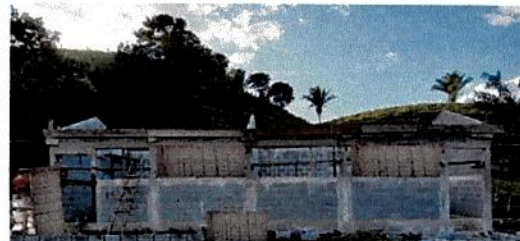
Foto 4: Desinstalación de balcones.
