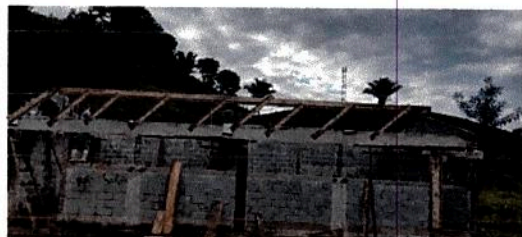
Foto 1: Desinstalación de estructura portante de madera.
