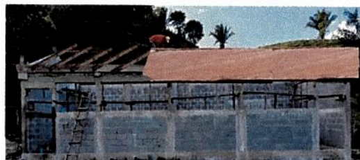
Foto 2: Desinstalación de lámina de aulas.
