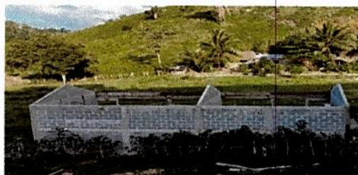
Foto 3: Desinstalación de techo de aulas.
