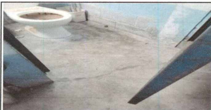
Foto 5: Cambio de Tazas y puertas de baños.
