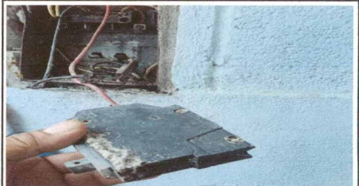
Foto 2: Cambio de Cableado de Energía Eléctrica.
