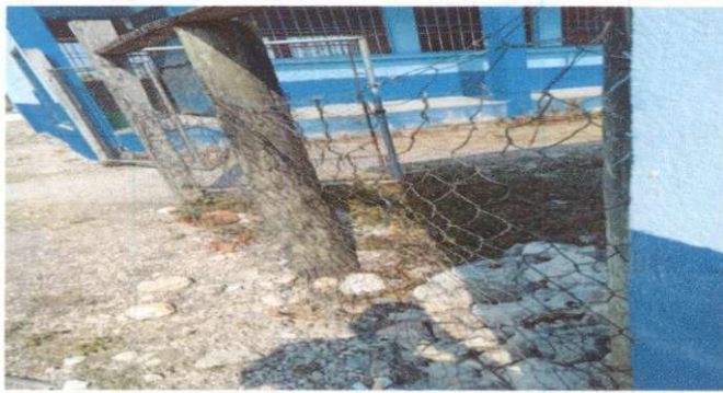
Foto 3: Reparación del muro perimetral ✓
