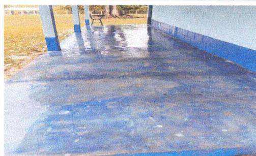
Foto 6: Sustitución de piso de cemento líquido
