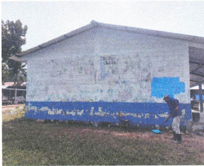
Foto 7: Pintura en muros exteriores e interiores
