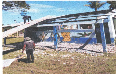
Foto 8: Desinstalación de lámina existente
