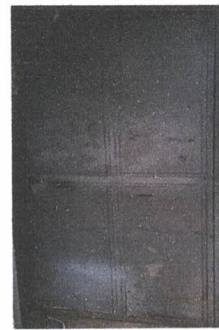
Foto 4: Sustitución de puerta en servicios sanitarios
