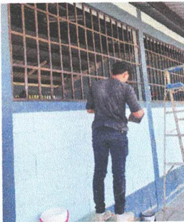
Foto 5: Mantenimiento a balcones de metal
