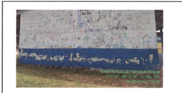
Foto 4: Pintura en muros exteriores e interiores
