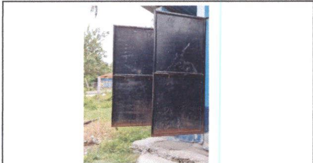
Foto 9: Sustitución de puerta en servicios sanitarios
