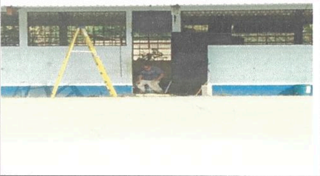
Foto 4 Renglon 4.3, sustitución de puertas en modulos
