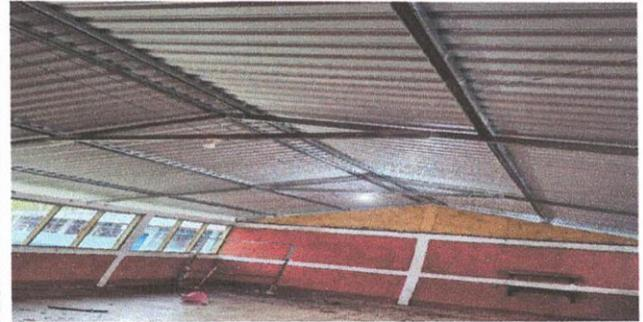
Foto 2: Se Culmino el suministro de lámina troquelada y capotes de módulo dos
