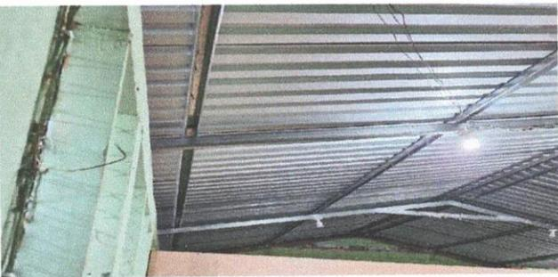
Foto 3: Se Culmina la instalación de capotes y lámina troquelada en módulo tres
