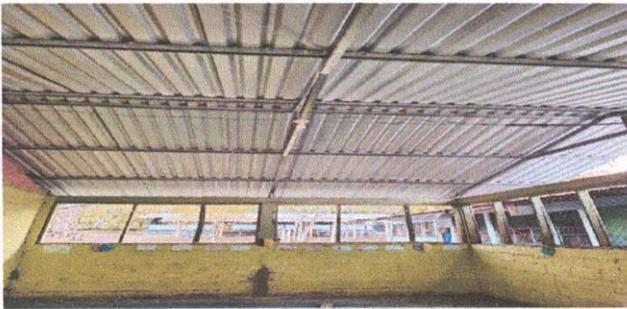
Foto1: Se culmino el suministro de lámina troquelada y capotes de un modulo
