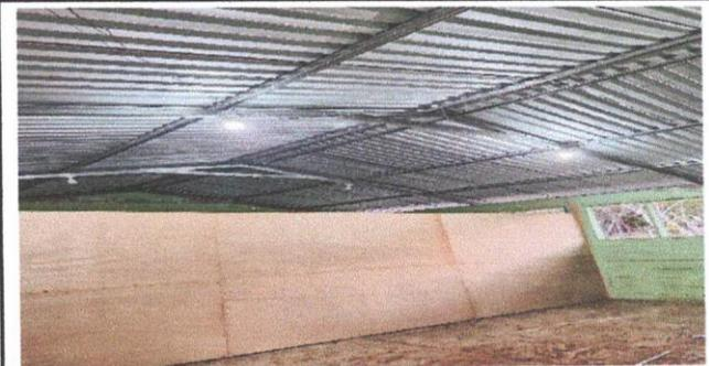
Foto 4: Se culmina la instalación de lámina troquelada y capotes en módulo tres
