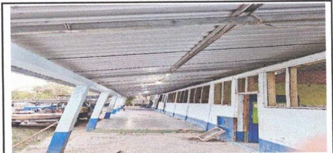
Foto 6: Culminación de lámina troquelada y capotes en el área de corredor de los tres módulos
