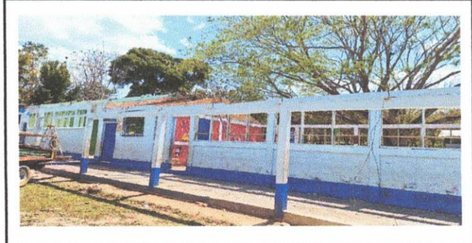
Foto 2: Se desmonto la estructura de láminas oxidadas y madera deteriorada
