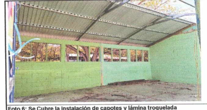
Foto 6: Se Cubre la instalación de capotes y lámina troquelada
