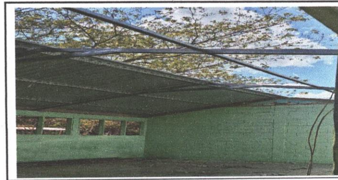
Foto 4: Empezaron el suministro de instalacion de capota y lámina troquelada
