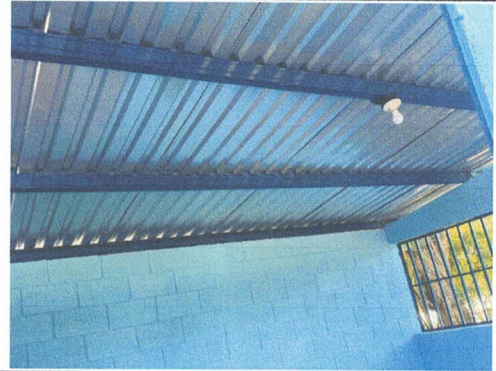
FOTO 2: Sustitución de estructura de soporte de madera por metal
