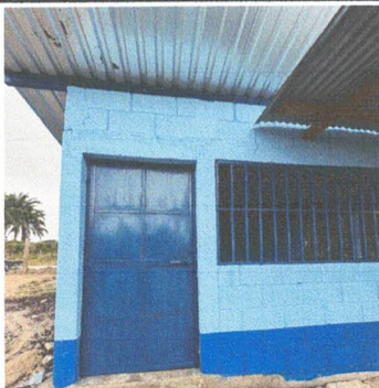
FOTO 5: Fabricación e instalación de puertas de metal en módulos.
