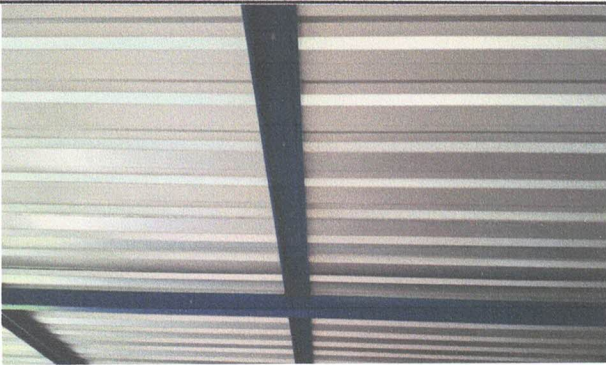
FOTO 3: Sustitución de elementos de fijación
