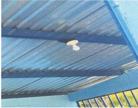
FOTO 7: Reparación del cableado eléctrico.
