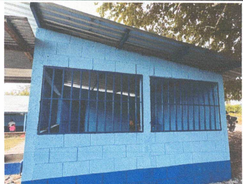
FOTO 4: Fabricación e intalacion de ventana-balcón de metal.
