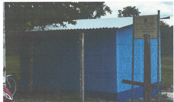
FOTO 6: Pintura en muros exteriores e interiores.
