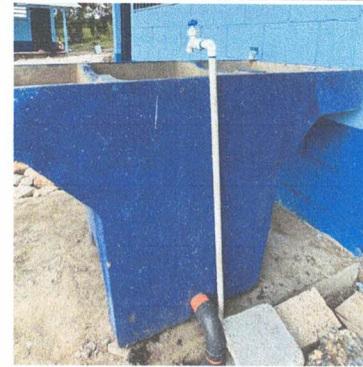
FOTO 8: Sustitución de tubería principal.
