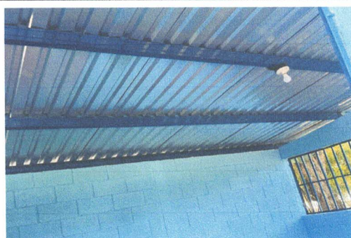
FOTO 10: Instalación de lámina troquelada Aluzinc.
