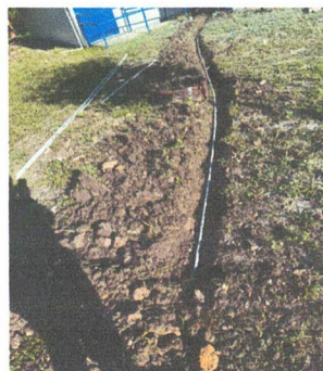
FOTO 8: Sustitución de tubería principal.
