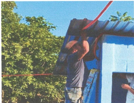
FOTO 7: Reparación del cableado eléctrico.
