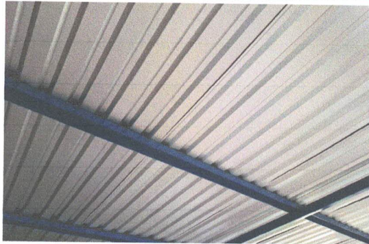
FOTO 1: Sustitución de lámina por lámina troquelada Aluzinc calibre 26
