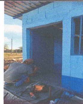
FOTO 6: Pintura en muros exteriores e interiores.
