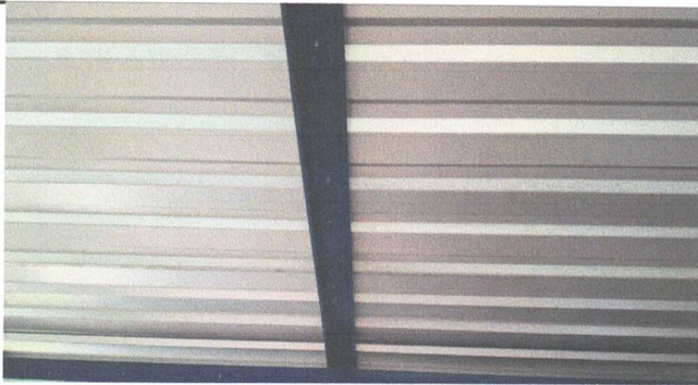
FOTO 3: Sustitución de elementos de fijación
