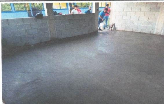
FOTO 9: Reparación de piso de cemento líquido.
