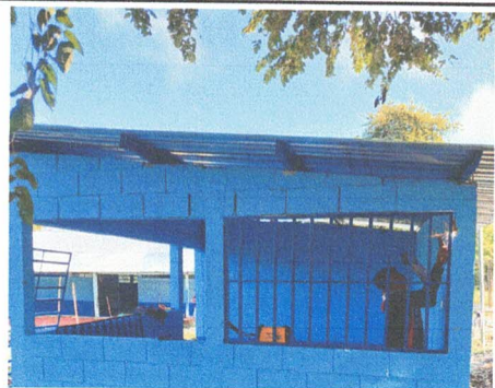
FOTO 4. Fabricación e intalacion de ventana-balcón de metal.
