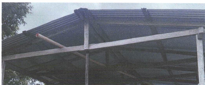
FOTO 3: Sustitución de capote de lámina para lámina troquelada.
