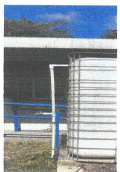
FOTO 9: Sustitución de tubería línea principal.
