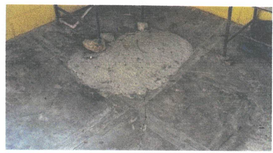
FOTO 10: Reparación de piso de cemento líquido.
