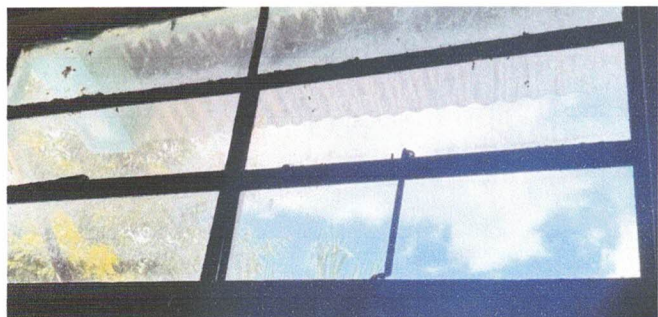
FOTO 5: Fabricación e instalación de ventana-balcón de metal.
