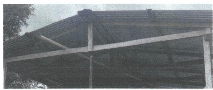
FOTO 11: Instalación de lámina troquelada Aluzinc
