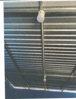
SUSTITUCIÓN DE LAMPARAS Y PLAFONERAS
