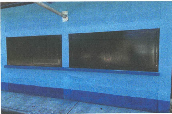
SUSTITUCIÓN DE VENTANAS DE METAL
