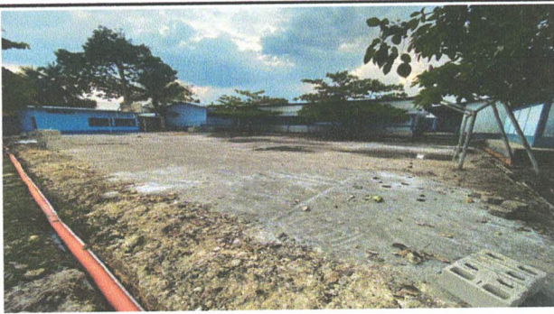
SUSTITUCION DE TUVERIA PVC LINEA PRINCIPAL
