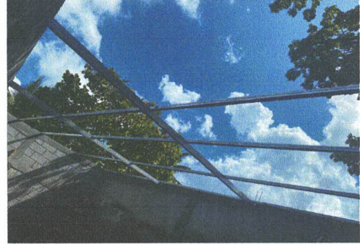
SUSTITUCIÓN DE ESTRUCTURA DE METAL
