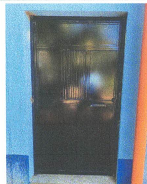
INSTALACIÓN DE PUERTAS DE METAL
