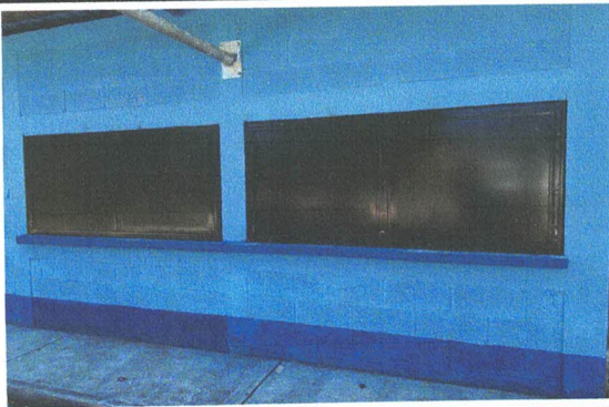
SUSTITUCIÓN DE VENTANAS DE METAL
