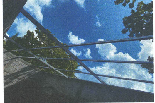
SUSTITUCIÓN DE ESTRUCTURA DE METAL
