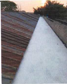
Foto 5: Impermeabilización de losa
