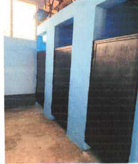
Foto 4: Mantenimiento de puertas.
