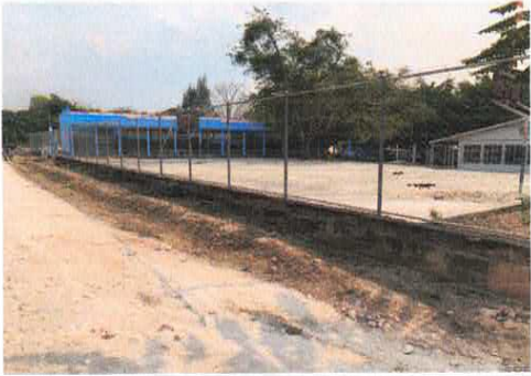
Foto1: Mantenimiento malla perimetral.
