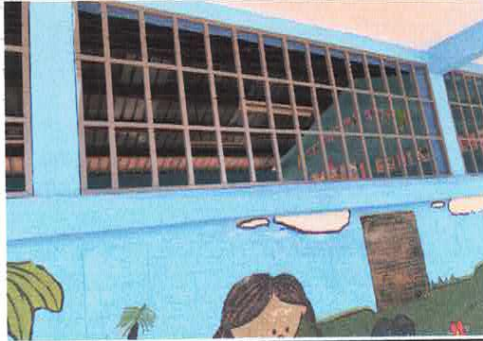
Foto 3: Sustitución de ventanas.
