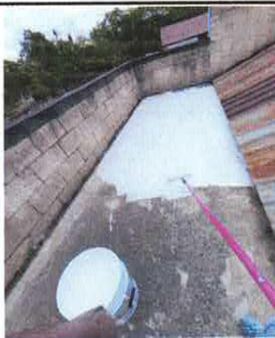
Foto 5: Impermeabilización de losa
