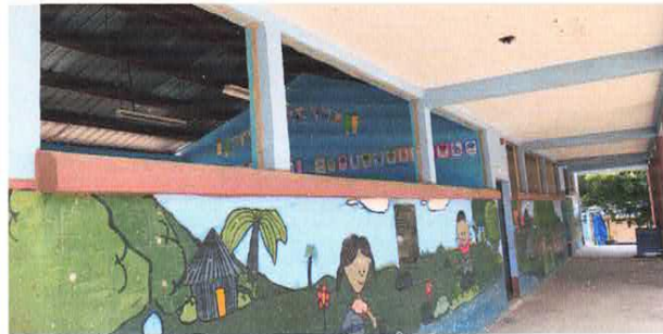
Foto 3: Sustitución de ventanas.
