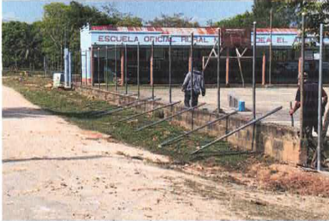
Foto 1: Mantenimiento malla perimetral.
