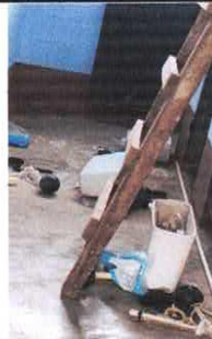
Foto 6: Sustitución accesorios de baños
