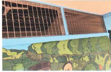
Foto 2: Mantenimiento de balcones.
