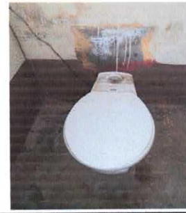
Foto 4: Sustitución accesorio de baños.
