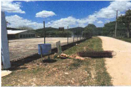
Foto 1: Mantenimiento malla perimetral.
