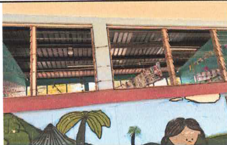
Foto 5: Sustitución de ventanas.
