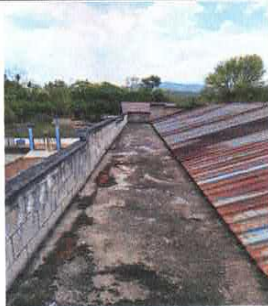
Foto 3: Impermeabilización de losa.
