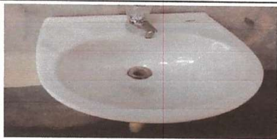
FOTO 5. INSTALACIÓN DE LAVAMANOS.
