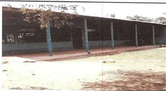
FOTO 3. PINTURA DE EXTERIOR
