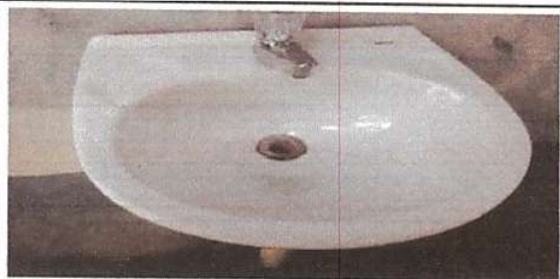
FOTO 5. INSTALACIÓN DE LAVAMANOS.
