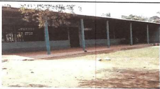
FOTO 3. PINTURA DE EXTERIOR
