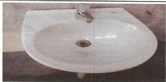
FOTO 5. INSTALACIÓN DE LAVAMANOS.
