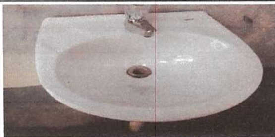
FOTO 5. INSTALACIÓN DE LAVAMANOS.
