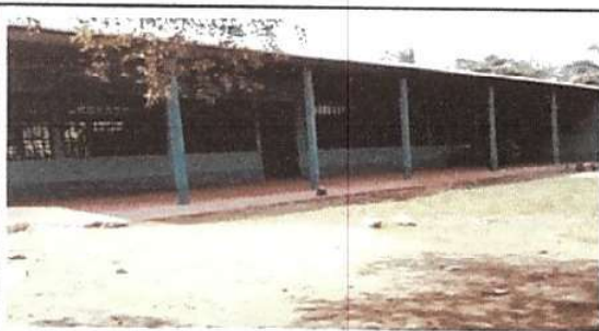
FOTO 3. PINTURA DE EXTERIOR
