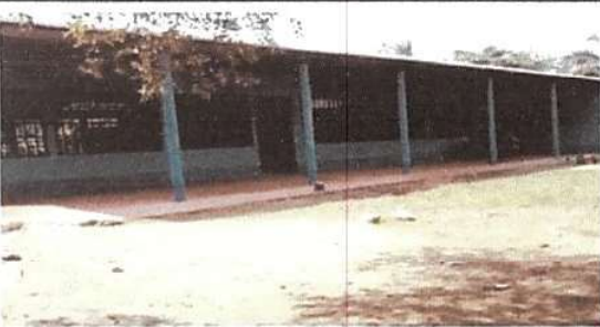
FOTO 3. PINTURA DE EXTERIOR
