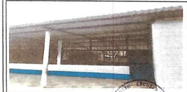
Reforzamiento de ventanales
