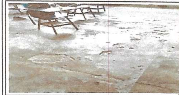
Cambio de piso
