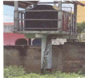
Foto 4: Sustrucción de tubería principal (Red de agua potable)
