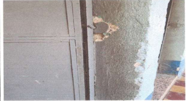
Foto 2: Mantenimiento de puertas
