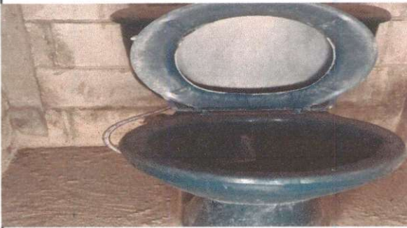
Foto 3: Sustrucción de azulejo en sanitarios
