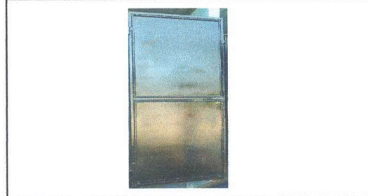
Foto 8: Fabricación e instalación de puertas de metal en baños
