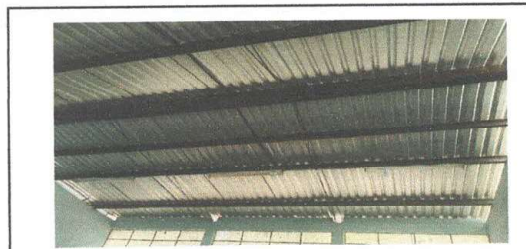
Foto 9: Instalación de lámina troquelada aluzinc
