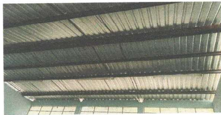
Foto 3: Mantenimiento a estructura (lijado, cambio de tubo, cepillado, sujeciones, aplicación de pintura)
