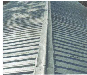
Foto 2: Sustitución de capote de lámina para lámina troquelada
