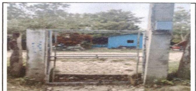
Foto 5 Renglon 4.5: Sustitución de porton principal 2.00 x 1.75 tubo galvanizado cal. 16
