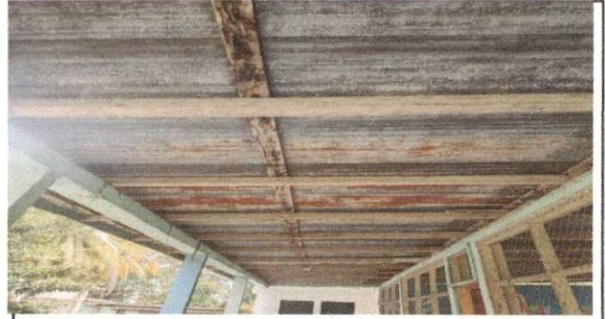
Foto 2 Renglon 2.2.Sustitución de soporte de madera por metal galvanizado cal. 16
