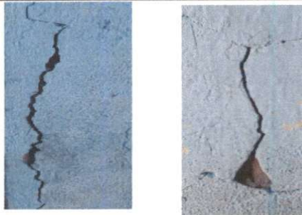
Foto 5: Sellado de grietas y fisuras en muros (Pared 1 y 2)
