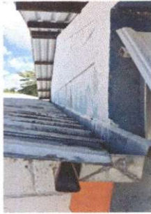
Foto 3: Sustitución de tubería de aguas pluviales
