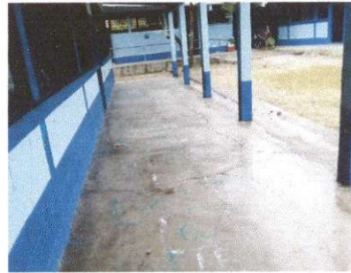
Foto 2: Sustitución de piso de cemento líquido
