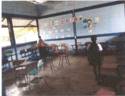
Foto 3: Pintura de muros interiores e exteriores
