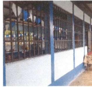
Foto 2: Mantenimiento a balcones
