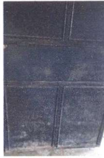
Foto 1: Mantenimiento a puertas de modulo
