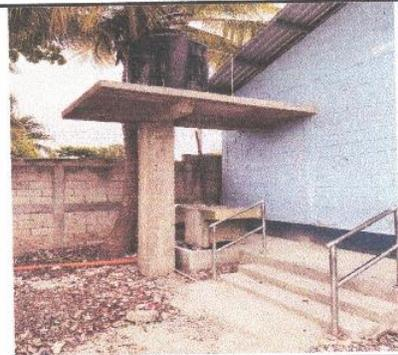
Foto 6: Construcción de base para depósito de agua
