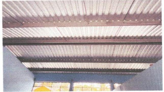
Foto 2: Cambio estructura de metal
