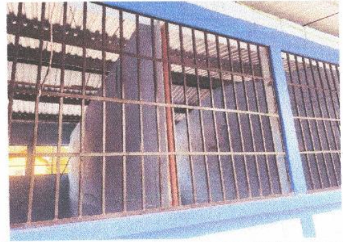
Foto 4: Cambio de balcones
