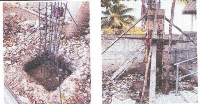
Foto 6: Construcción de base para depósito de agua
