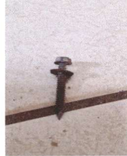
Foto 2: Sustitución de elementos de fijacion
