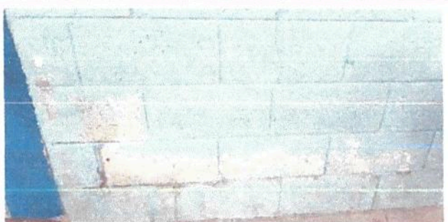
Pintura en muros exteriores e interiores
