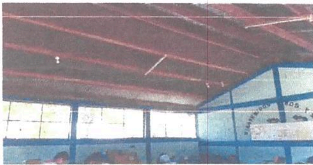
Mantenimiento a estructura de soporte de metal
