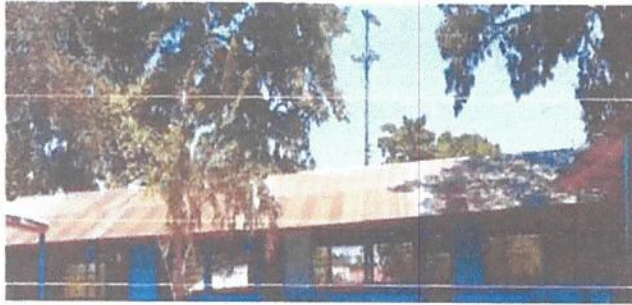
Sustitución de lámina, por lámina troquelada aluzinc calibre 26
