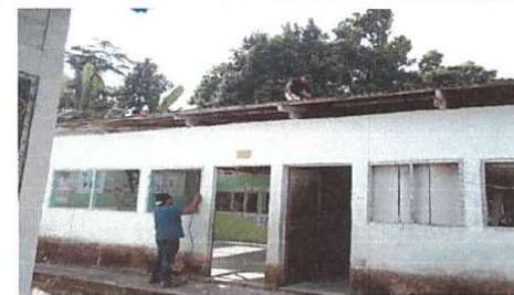
Sustitución de ventanas de madera por metal
