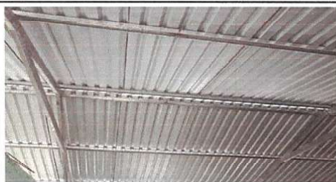
Sustitución de lámina por lámina troquelada
