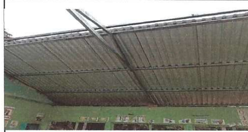
Sustitución de estructura de madera, por metal
