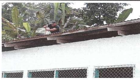
Sustitución de lámina troquelada aluzinc calibre 26
