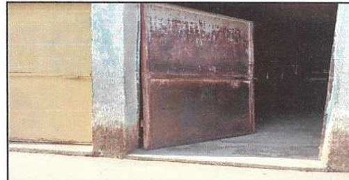
Sustitución de Puerta
