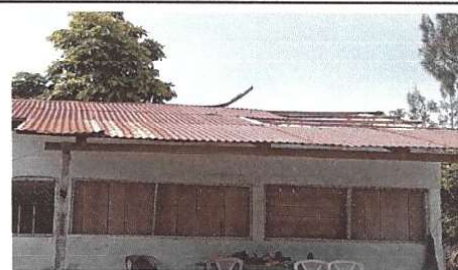
sustitución de ducto electrico + accesorios
