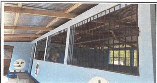
Foto 4: Se esta sustituyendo balcones de madera por balcones de metal
