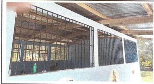
Foto 1: Se estan reemplazando balcones de madera por balcones de metal
