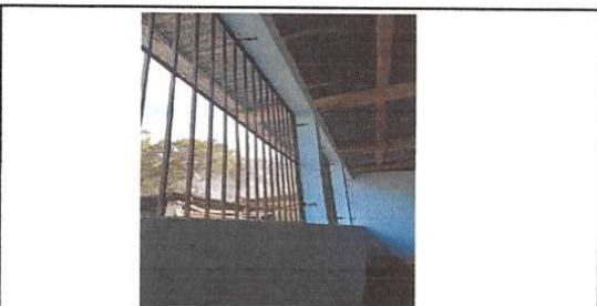
Foto 6: Se sustituyo ventana de malla por balcon de metal
