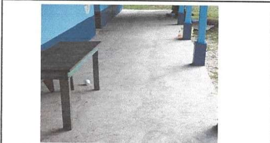
Foto 3: Se esta sustituyendo piso en mal estado por piso nuevo
