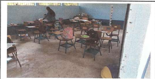
Foto 5: Se sustituyo piso en mal estado por piso nuevo
