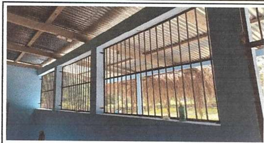
Foto 2: Se estan sustituyendo balcones de madera por balcones de metal
