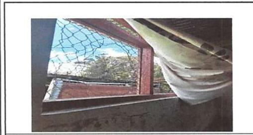
Foto 5: Se sustituirá mayas rotas de balcones de madera por balcones de metal
