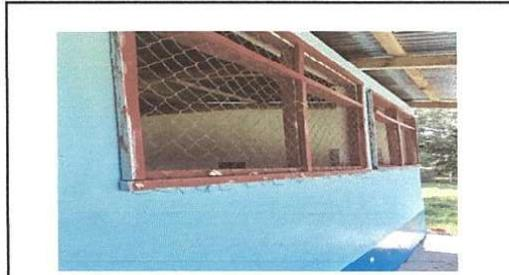
Foto 2: Se reemplazara balcones de madera por balcones de metal
