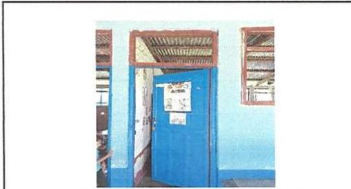
Foto 1: Se sustituirá puerta de madera por puerta de metal
