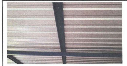
Foto 10: Instalación de lámina troquela aluzinc
