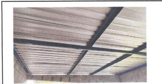
Foto 9: Instalación de estructura portante de metal
