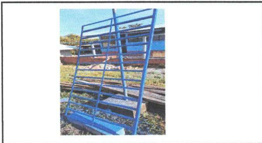
Foto 7: Fabricación e instalación de balcones de hierro en ventana
