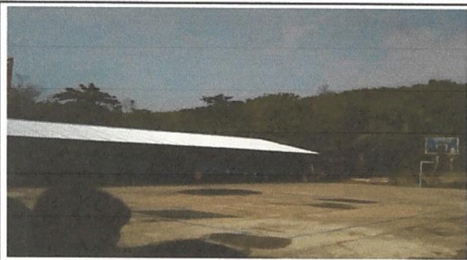
Foto 3: Cambio de techo.
