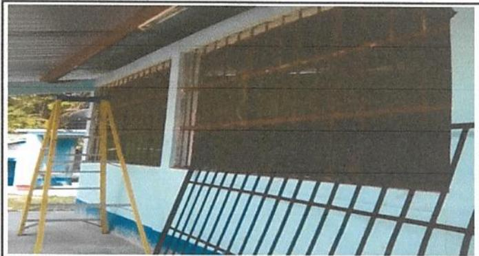
Foto 4: En proceso de colocación de balcones nuevos.
