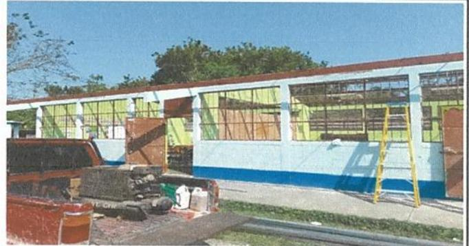
Foto 2: Retiro de balcones en mal estado
