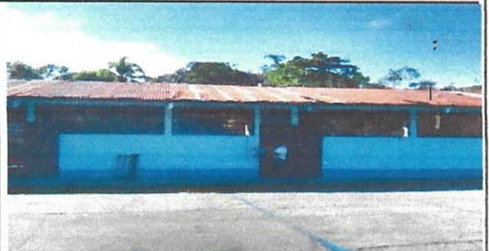
Foto2: Cambio de estructura de techo por lamina troquelada de 26 pies
